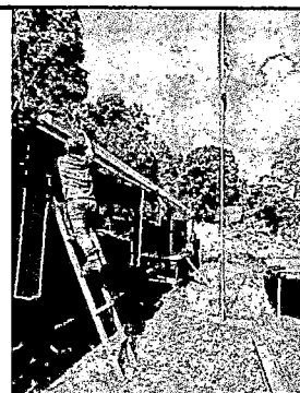
Foto 4: Drenaje pluvial (Colocación de canales)
